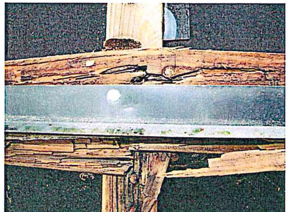
Fest steht, dass die Bleche, die auf den waagrechten Holzträger montiert wurden, Schuld am Schaden sind.
